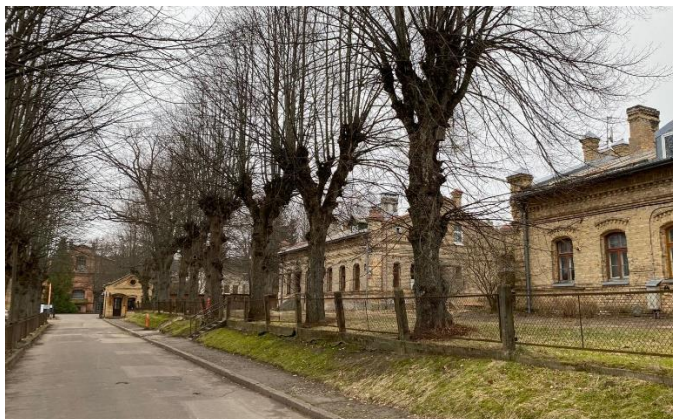
Attēls Nr. 56. Sūkņu stacijas "Baltežers" vēsturiskā apbūve (Grupa93, 2024)
