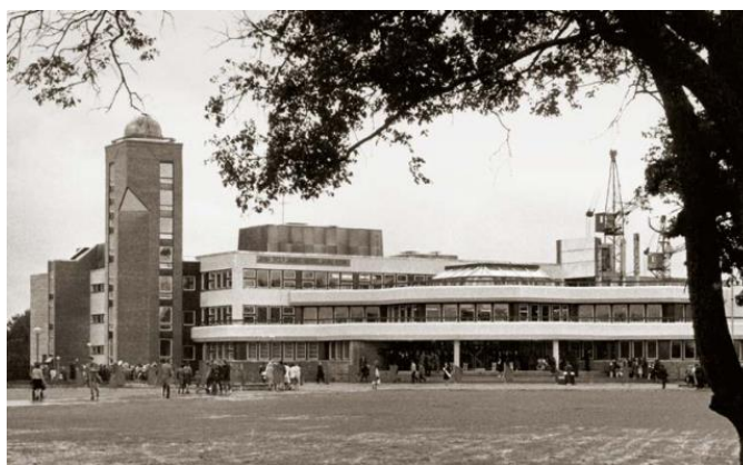
Attēls Nr. 17. Padomju modernisma stilā celta Ādažu vidusskolas ēka 24
