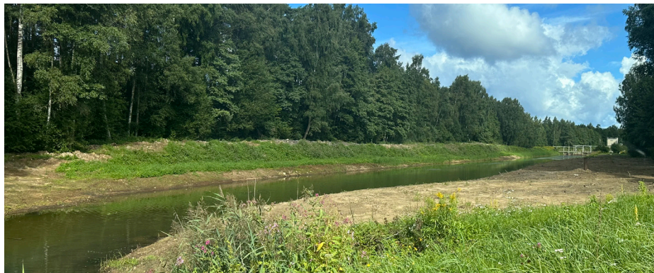
● Meliorācijas ūdensnoteka Ādažu novadā, kas nodrošina liekā ūdens novadīšanu no apkārtējām teritorijām un palīdz mazināt applūšanas risku.
