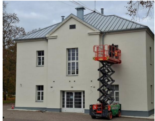
1.7.10. TN Ozolaine fasādes remonts
