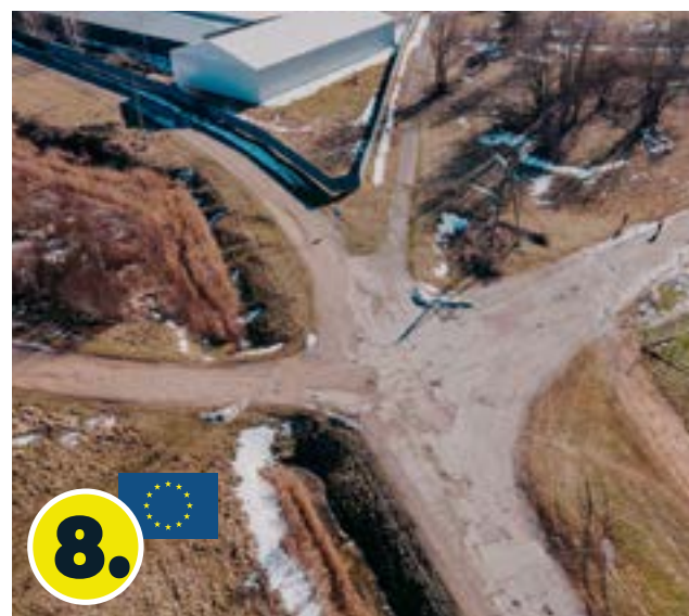
8. Infrastruktūras uzlabošana uzņēmējdarbības attīstībai Ādažos, 1. kārtā (Jaunkūlu ielā).
