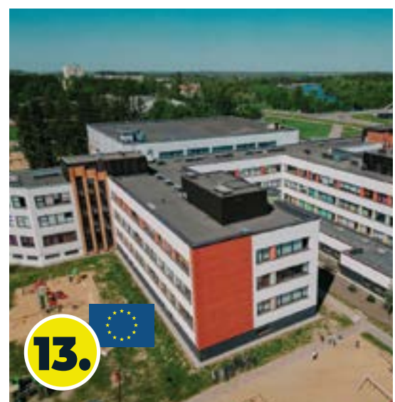
13. Ādažu vidusskolā āra lifta izbūve pie A korpusa, A, B un D korpusa siltināšana, mācību telpu pārbūve.
