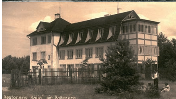
Ernesta Fāļa būvobjekti – Baltezers paviljons 1927. gads.
