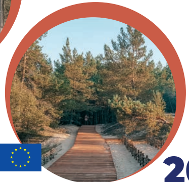
22. Mežaparka ceļa pārbūve
