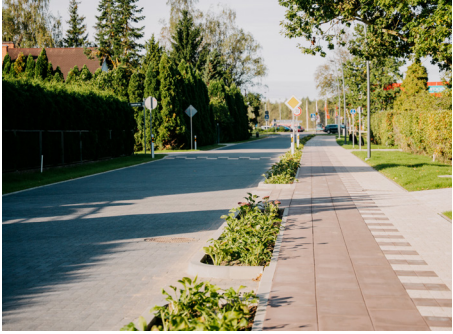
Ķiršu ielas pārbūves darbi ir pabeigti. Objekts tiks nodots ekspluatācijā pēc papildu darbu grāvja pārbūvē gar Rīgas gatvi pabeigšanas.
