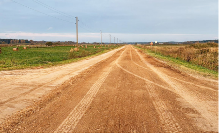
Grantēto ielu un ceļu greiderēšanas darbi notiek prioritārā secībā atbilstošos laika apstākļos. Novada ielu un ceļu segumu uzlabošana ar minerālmateriāliem vai frēzēto asfaltbetonu turpināsies visu rudens periodu.
