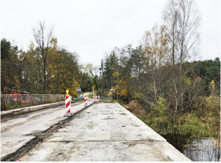
Uzsākti tilta pār Dzirnupi pārbūves darbi, kas turpināsies līdz 2026. gada jūnijam. Satiksme pār Dzirnupes tiltu ir organizēta pa vienu joslu ar luksoforiem.
