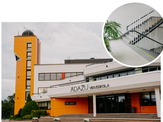
● Ādažu vidusskolā pabeigta A korpusa siltināšana, trešajā stāvā veikts gaitēņu remonts.
