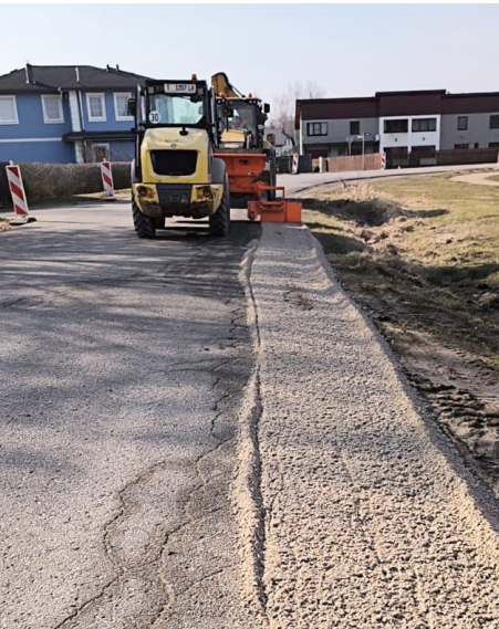
● Nomaļu uzpildīšana un bedrīšu remontdarbi Kanāla ielā, Ādažos.
