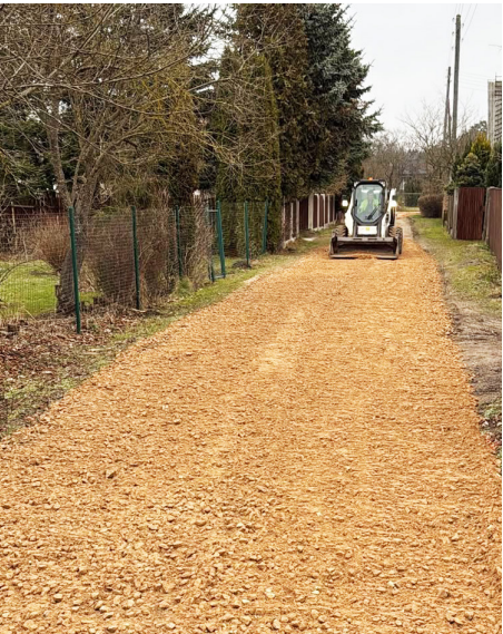
● Lokālo iesēdumu remonts ar grants-šķembu maisījumu Vāveru ielā, Garciemā.
