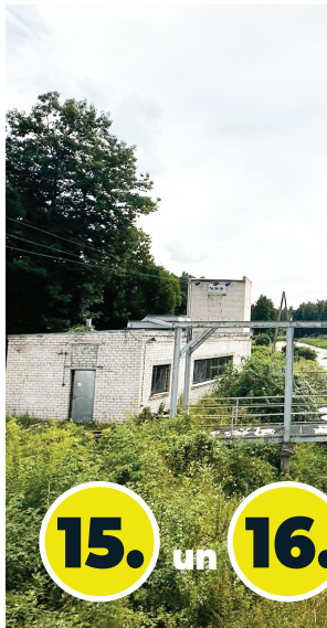
Laveru sūkņu stacija Mangaļu sūkņu stac būvprojekta izstrādē
