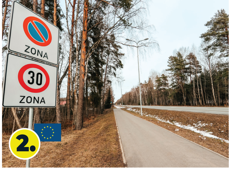
Maģistrālās veloceļu infrastruktūras būvniecība prioritārajā koridorā Rīga-Carnikava.
