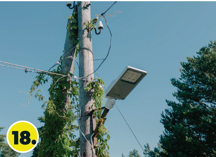
ielas apgaismojuma infrastruktūras paplašināšana Attekas ielā, Ādažos. No dzelzceļa stacijas "Gauja" līdz Skautu, Metāna un Ostvalda ielu krustojumam. Rūpnieku ielā, Carnikavā.
