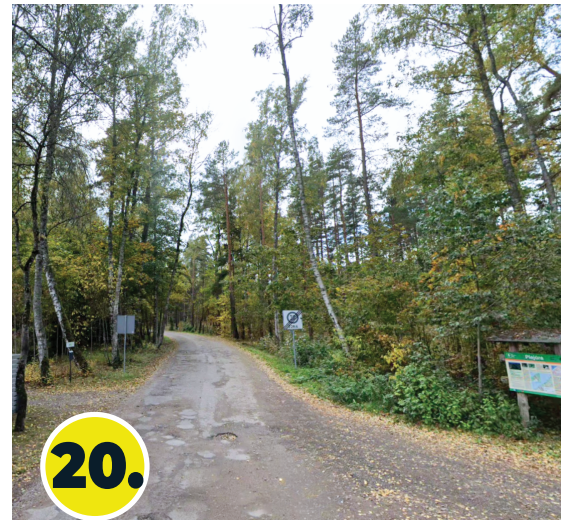
Torņu ielas asfaltbetona seguma atjaunošans posmā no autoceļa P1 līdz Langas ielai.
