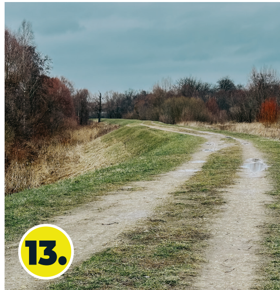
Gaujas aizsargdambja virskārtas uzlabošana – grants seguma izbūve
