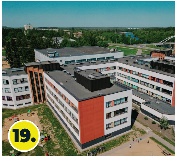
Ādažu vidusskolā āra lifta izbūve pie A korpusa. Ēkas siltināšana A, B un D korpusos.
