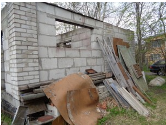
1.1.1-1 Dārza māja -jaunbūve (pamati un konstrukcija) atbilst Grausta statusam
