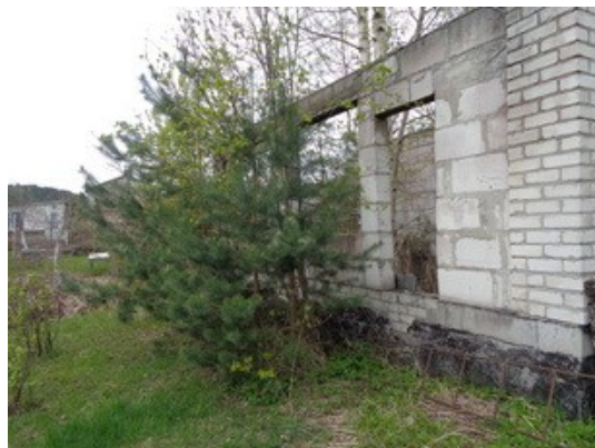
1.1.1-2 Dārza māja -jaunbūve (pamati un konstrukcija) atbilst Grausta statusam
