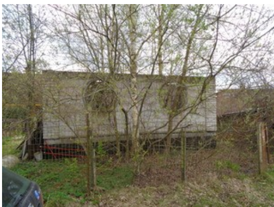
1.1.1-9 Dārza māja -jaunbūve (pamati un konstrukcija) atbilst Grausta statusam
