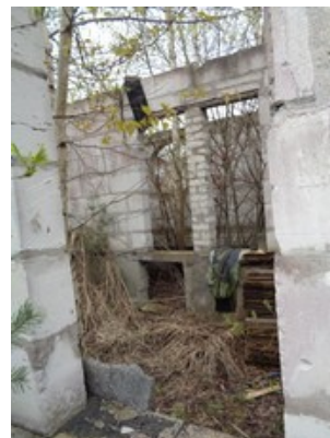
1.1.1-8 Dārza māja -jaunbūve (pamati un konstrukcija) atbilst Grausta statusam
