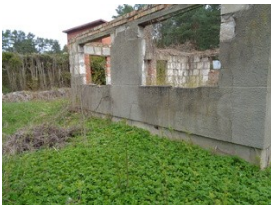
1.1.1-9 Dārza māja (pamati un konstrukcija) atbilst Grausta statusam
