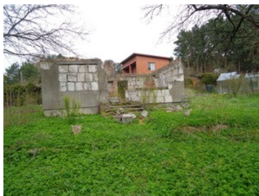
1.1.1-6 Dārza māja (pamati un konstrukcija) atbilst Grausta statusam
