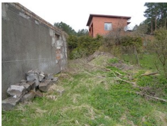
1.1.1-7 Dārza māja (pamati un konstrukcija) atbilst Grausta statusam
