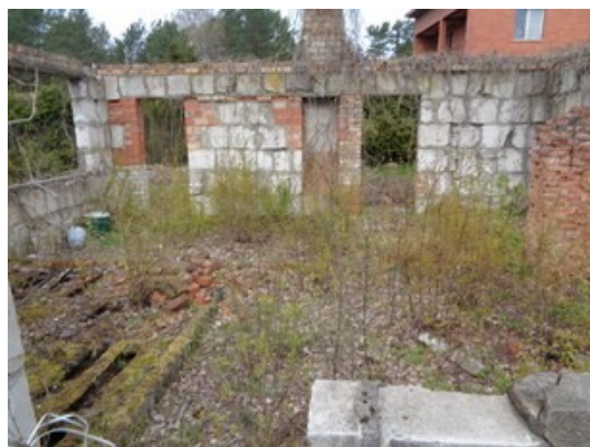
1.1.1-8 Dārza māja (pamati un konstrukcija) atbilst Grausta statusam
