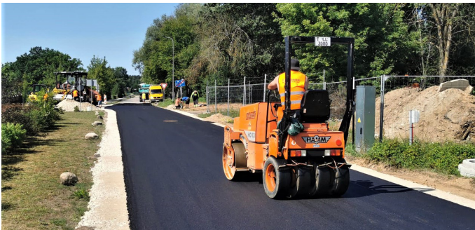
Asfaltbetona seguma izbūve Gaujmalas ielā, Ādažos
