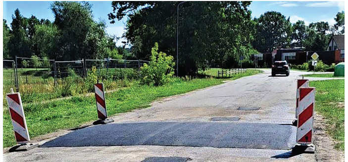
Ūbeļu ielā, Ādažos, uzstādīts ātrumvaļņi
