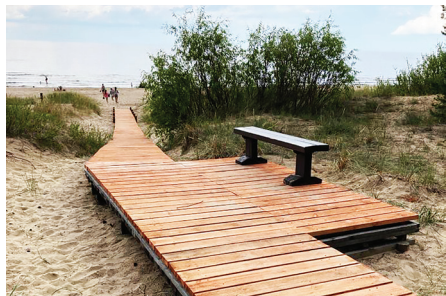
Izgatavots un uzstādīts 58m garš celiņš Garupē
